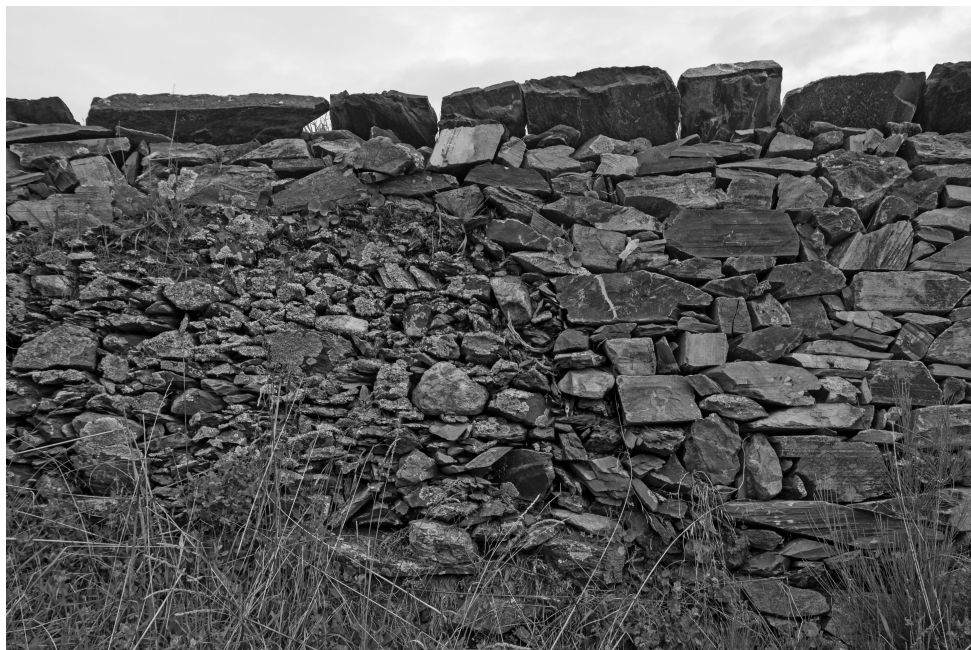
Figura 8. Detalle de pareón de una era de Monsagro. A la izquierda parte antigua, recubierta de líquenes. A la derecha, tramo restaurado.
