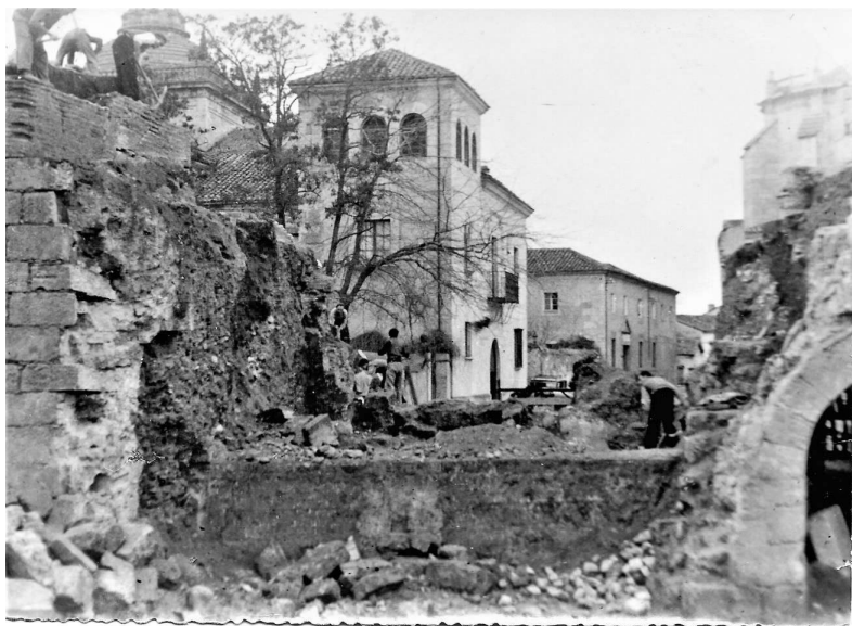
Figura 25. En el centro de la imagen se observa la primitiva atarjea al derribar el paramento de la muralla.
