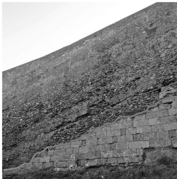
Figura 2. Detalle de la muralla de Ciudad Rodrigo en los anexos a la Puerta de la Colada.
