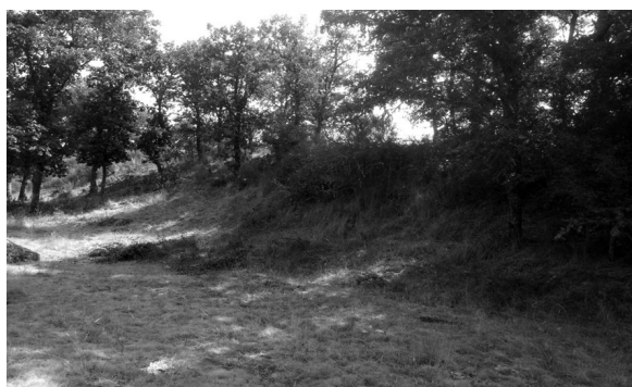
3. Foto de la pared o contención de la presa en la actualidad.
