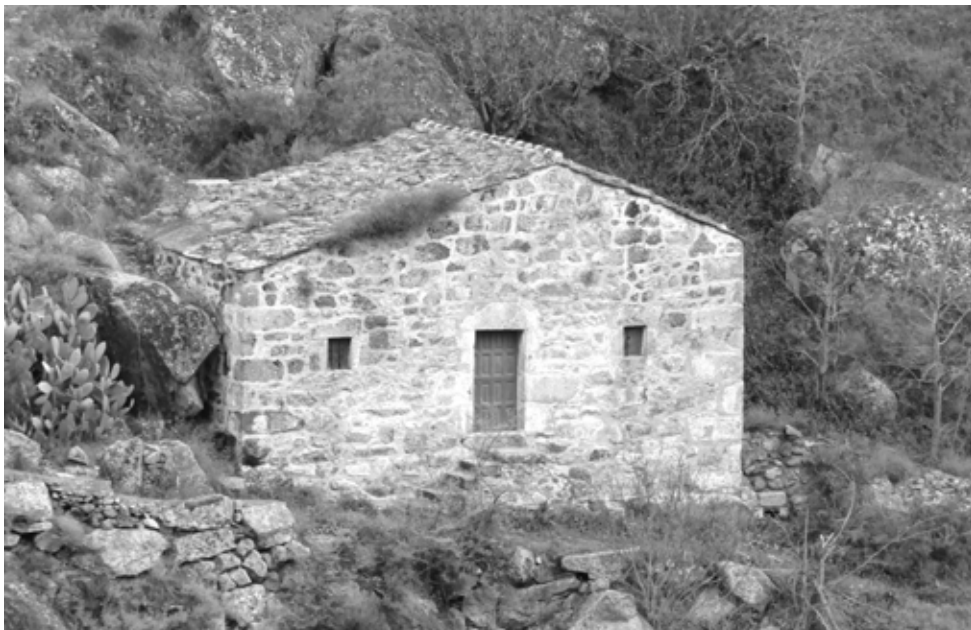
Figura 4. Casa de los Guardias, situada en la orilla de San Felices. Fue utilizada por los centinelas franceses que guardaban el extremo oriental del puente.
